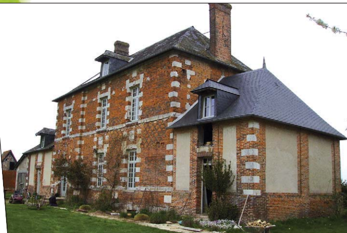
Les bâtiments d'habitation
